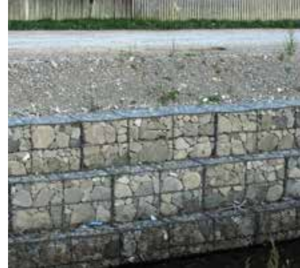
A patakok parterősítése (kikövezése) tovább fokozza a meder már eddig is előrehaladott bevágódását
